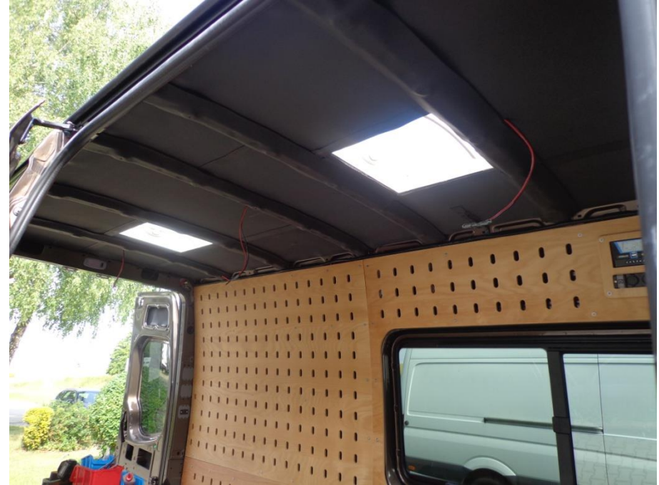
Deckenisolierung mit 2 Dachfenster
